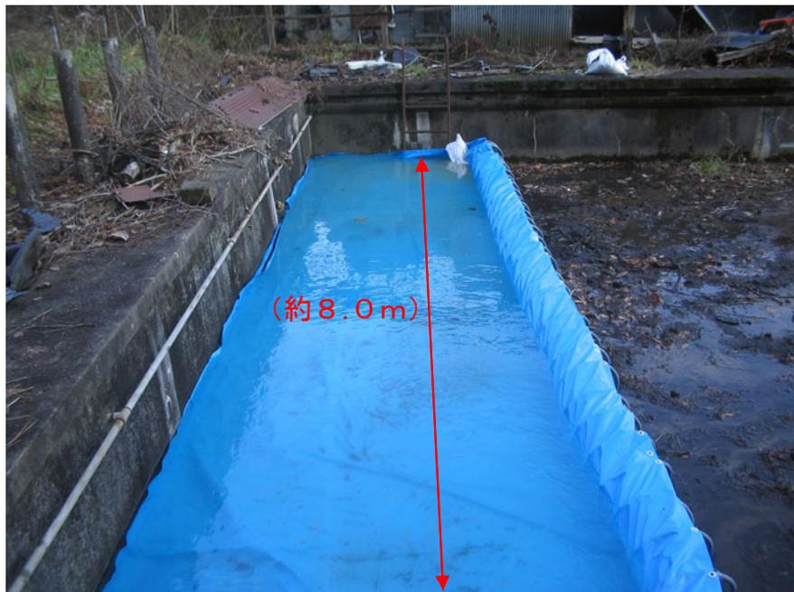
○ 螺旋支持具の直線状設置における入水口部状況
